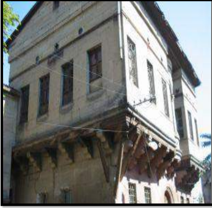
Şekil 5. Geleneksel Kayseri konutunda çıkma/konsol detay (URL 3, 2019)
