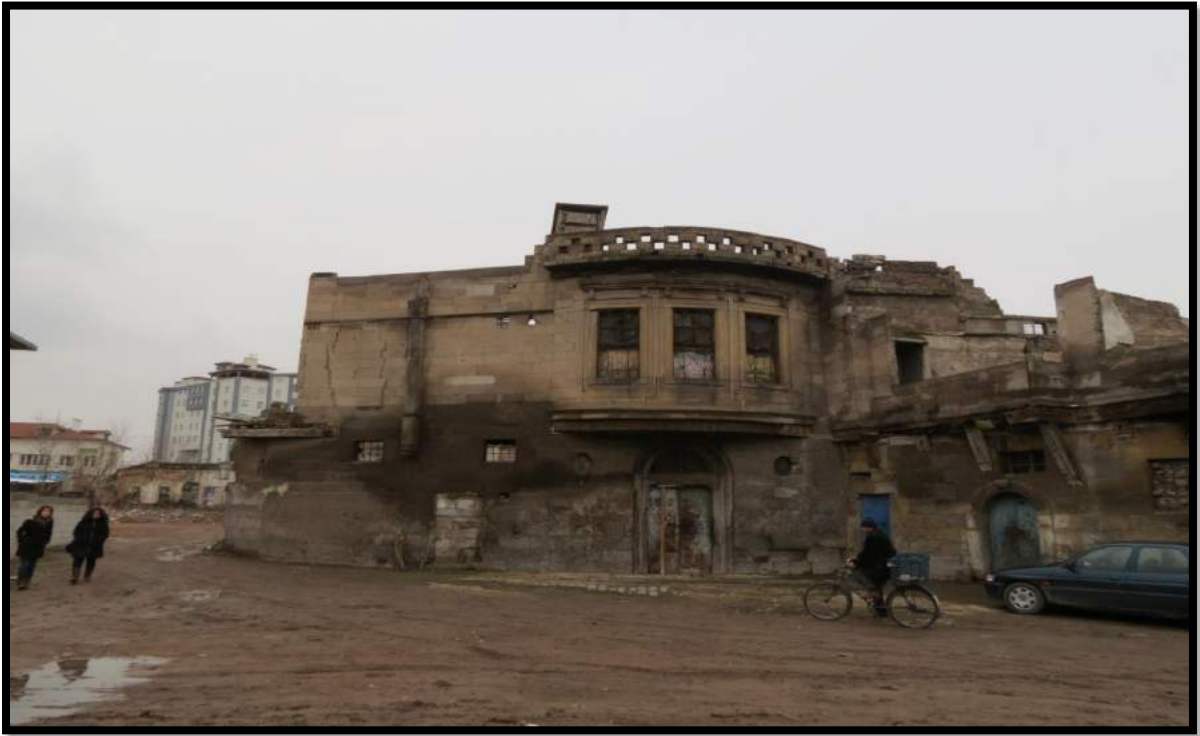
Şekil 3 Tavukçu Mahallesi 30-31 Parseldeki Geleneksel Konut Cephesi (URL 1, 2019)
