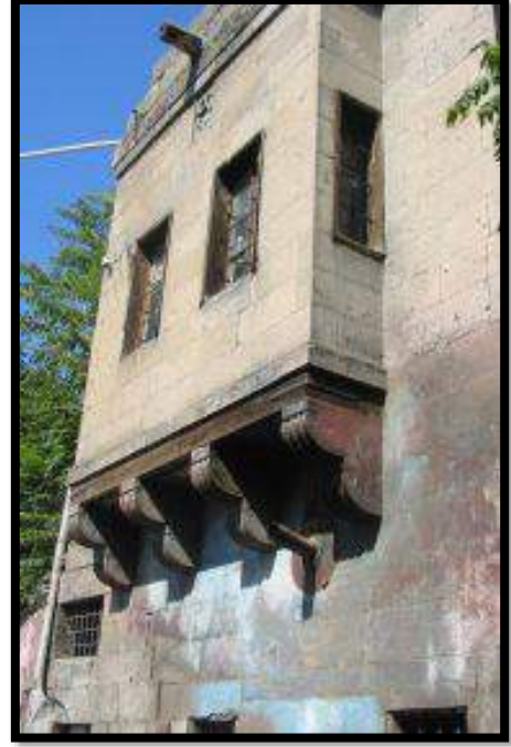
Şekil 5. Geleneksel Kayseri konutunda çıkma/konsol detay (URL 3, 2019)
