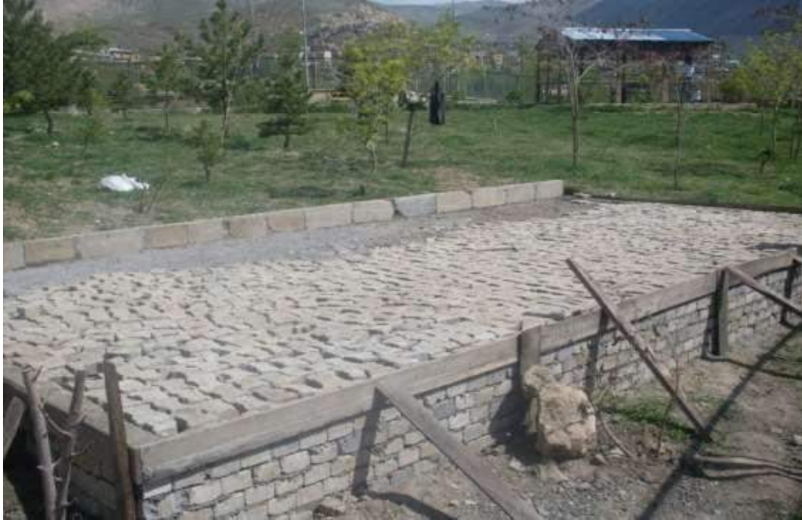
Şekil 2. Seranın temeli için kurulum resmi
