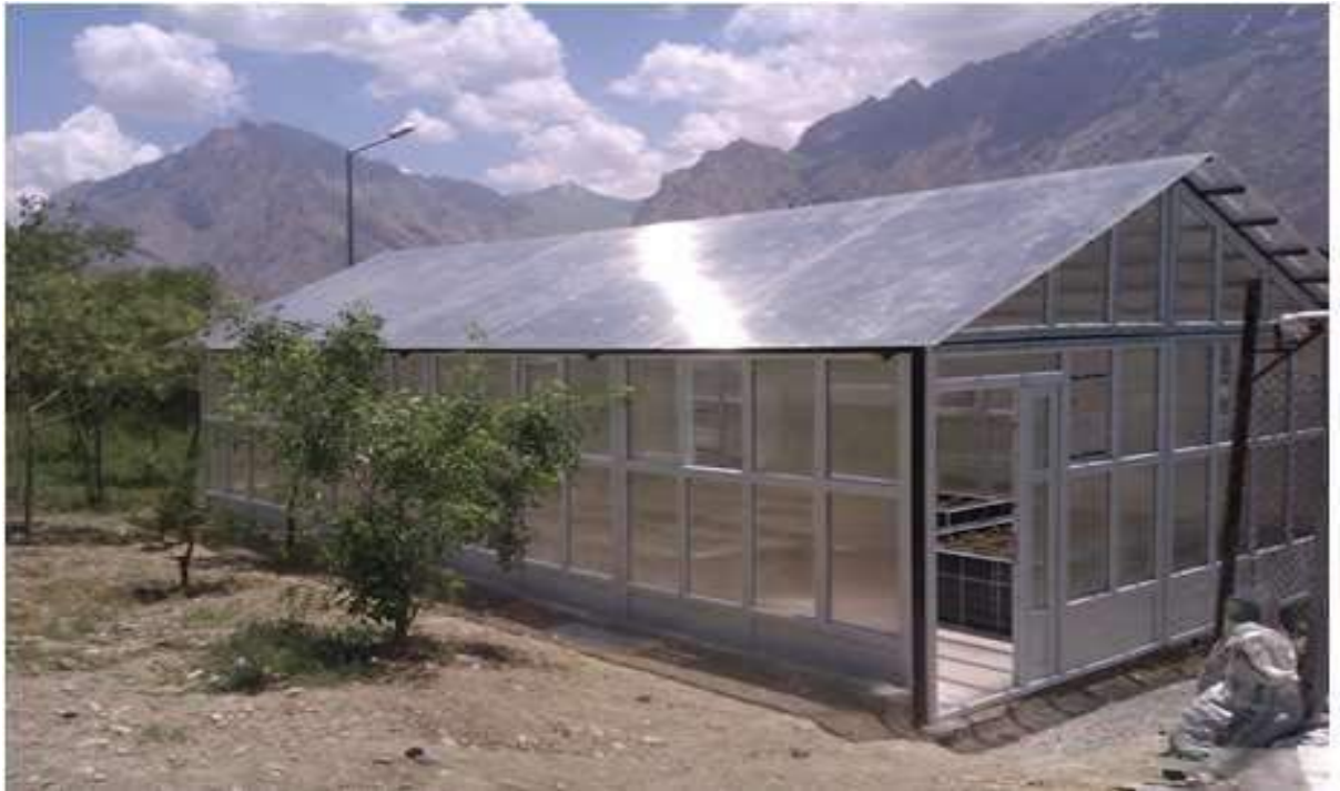
Şekil 4. Seranın Polietilen karbon ile kaplanmış hali
