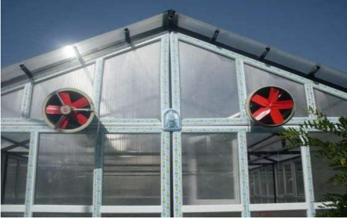
Şekil 7. Kurulumu yapılan seranın havalandırma sistemi
