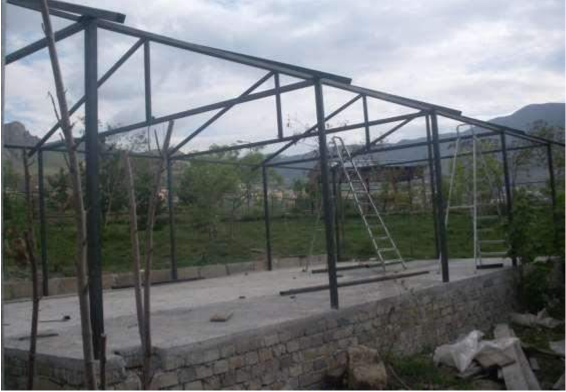
Şekil 3. Seranın temeline demir konstrüksiyonun kurulumu
